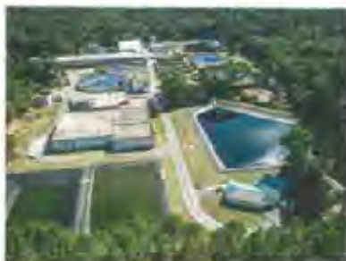
La station d'épuration située à Saint-Palais traite près de 70% du volume d'eaux usées du Pays Royanais. © C.A. - L'Estuaire Media
